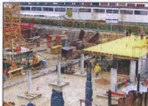
An der Blumenstraße in Regensburg entsteht der Energiepark. FOTO TEWAG
