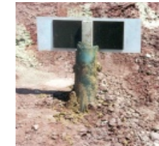
Unteres Ende eines Flachpegels in der Baugrube
